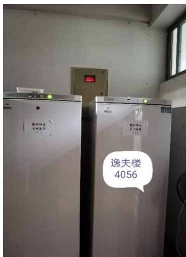
逸夫楼 4056—设备遮挡配电箱。负责人马喆（左图为初查，右图有复查）
