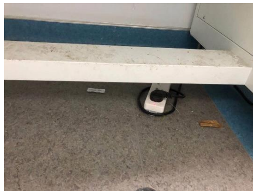
逸夫楼 5031-5033—接线板直接置于地面使用。负责人李盛本、熊国胜 (左图为初查, 右图为复查)
