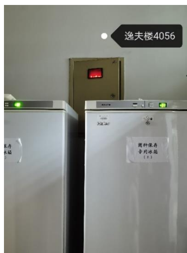
逸夫楼 4056—设备遮挡配电箱。负责人马喆（左图为初查，右图有复查）
