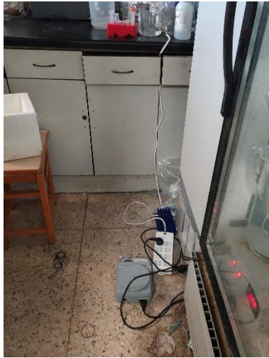
生科楼 C7021—接线板直接放置于地面使用，负责人曹慧（左图为初查，右图为复查）
